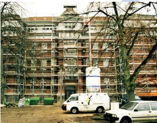
▲ Sanierung Pestalozzi-Gymnasium Guben
